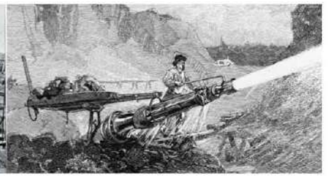
гидромонитор для смыва горных пород впервые был применен на Урале
